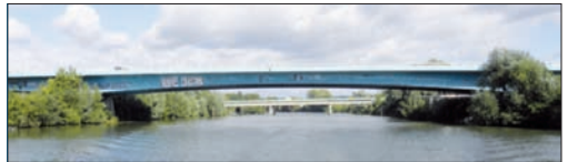
Pont de l'A 16
