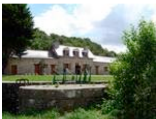
Vie Eclésièr (écluse de Rosvéguen)
